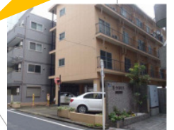
既存建物は4階建てでした
