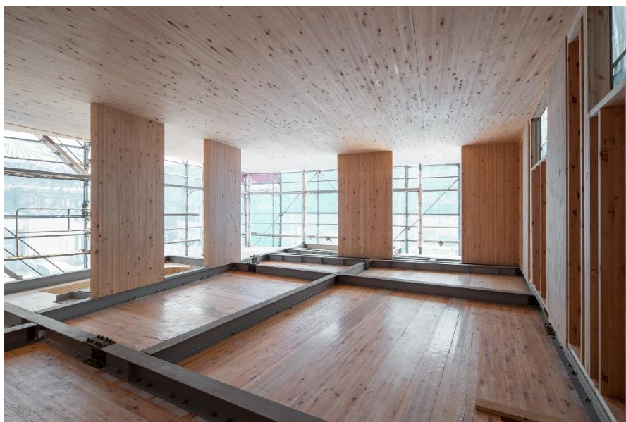
「FMT 構法」の施工現場写真(梁のないフラットな天井と大空間を実現)
