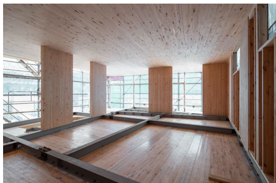
【「FMT 構法」の施工現場（三菱地所ホームモデルハウス）】
