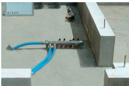
1cmあたり約240Kgもの荷重に耐える高強度コンクリートと密度の高い配筋を一体化させた強固な基礎に加え、将来の配管の交換を容易にする「さや管方式」を採用し、耐震性と維持管理に優れた基礎を実現します。
