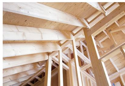
2×4工法の家は、壁・床・天井の6つの面で、箱形構造を形成することで、水平・垂直いずれの外力を受けても、建物全体でバランスよく受け止め、分散して吸収します。震度7クラスの大地震や、瞬間最大風速約50mの大型台風にも、ゆとりをもって耐えられるすぐれた安定強度を誇ります。
