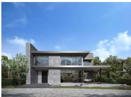
「ハイプロテクトウォール構法」と、「3D TIMBER FRAME」によって可能となった大空間と 8m の連続両面大開口に加え、CLT※を床版に使用することで2方向はね出しによる伸びやかな軒下空間を生み出した。
